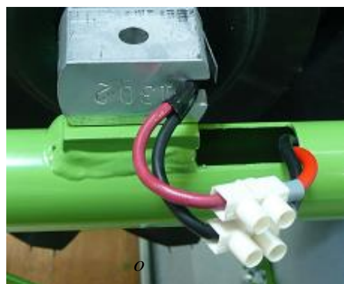
obr. č. 5. - kabeláž
